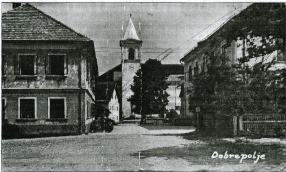
Šolska stavba na levi strani slike je bila zgrajena med leti 1857 - dokončno opremljena 1862, dozidana pa 1894.
