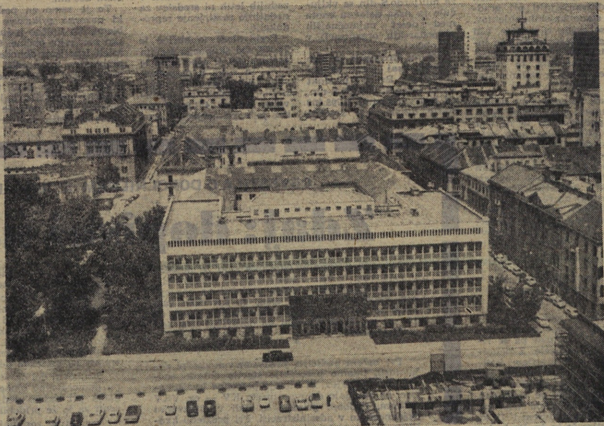
Pogled proti severu z okna stolpnice C na Trgu revolucije. Prispevek o nadaljevanju del na bodočem Trgu revolucije, pri katerih je udeleženo tudi naše podjetje, berite na straneh 6 in 7 z naslovom »Tudi pri instalacijah visok standard«
