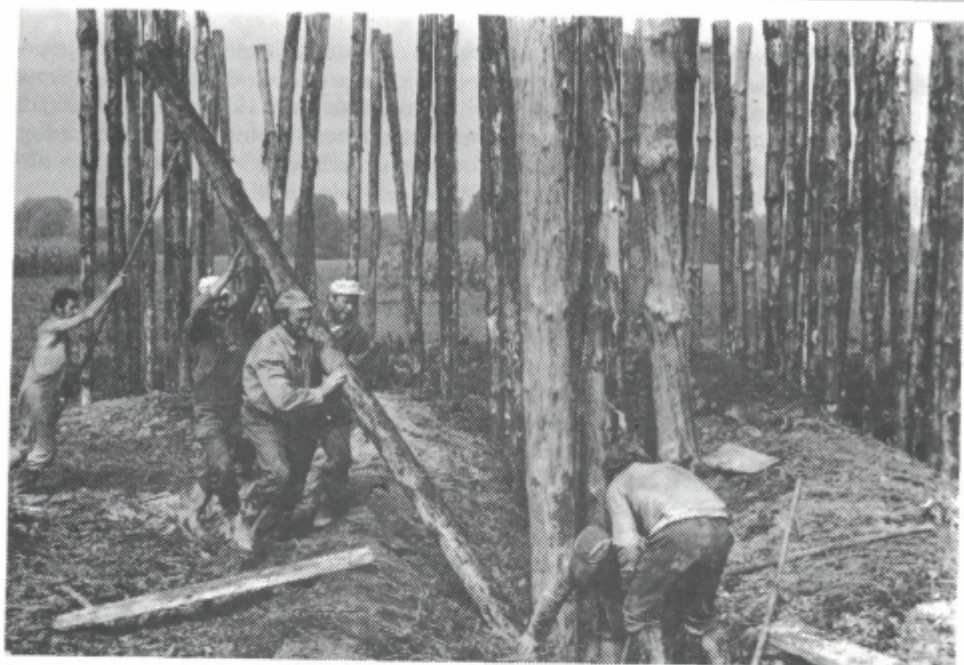
Sl. 9. Postavljanje pilotov za temelje nove hiše na Barju (1983).
