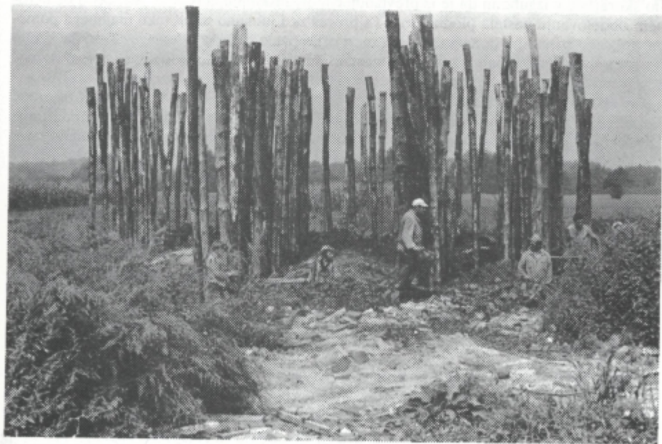
Sl. 10. Na dolžinski meter novih temeljev postavijo približno 3 okrog 10 metrov dolge pilote, ki jih s tanjšim delom, obrnjenim navzdol, nato zabijejo v zemljo (1983).
