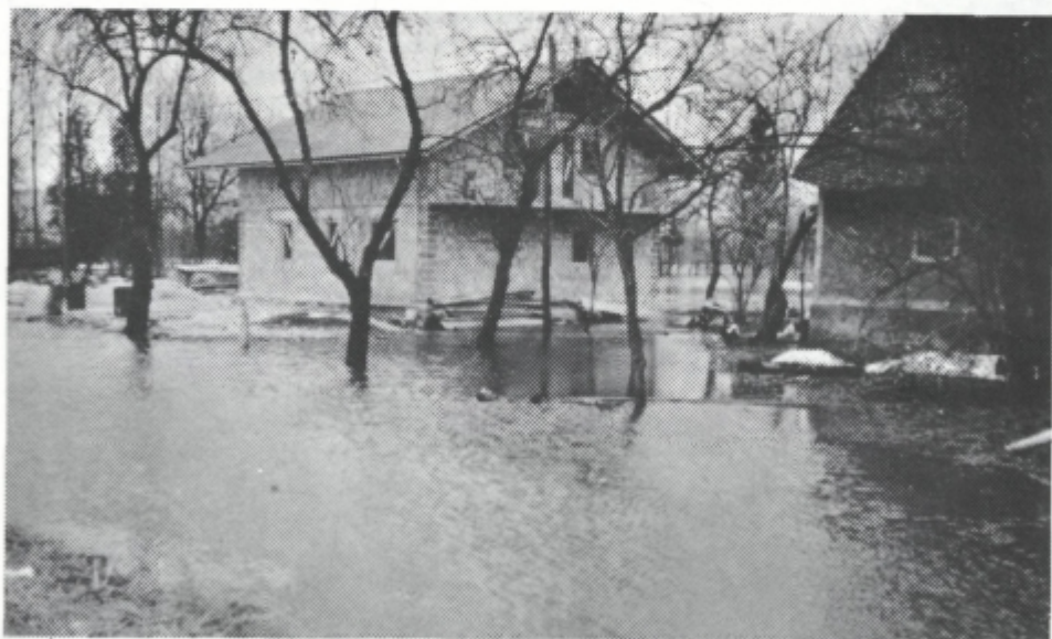
Sl. 11. Ob starejšem gospodarskem poslopju so zgradili novo stanovanjsko hišo, ki je obdana z vodo. Mnogokrat graditelji novih stavb ne dvignejo dovolj visoko temeljev, da bi bili nekoliko bolj varni pred poplavami, čeprav so starejše stavbe tako zgrajene (3. 1. 1982).
