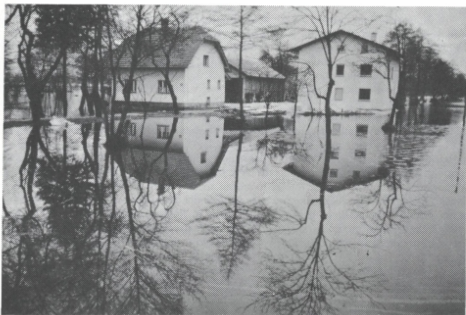
Sl. 19. Poplavljene so obsežne površine ob Ižanski cesti (3. I. 1982).
