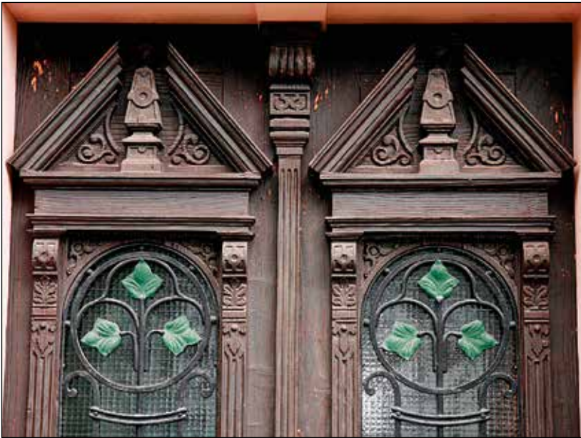
Detajl zgornjega dela vratnih kril Kemperlove hiše.
