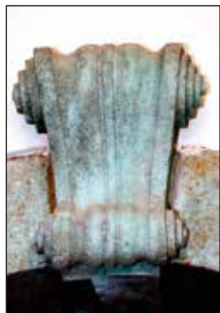
Detajl zgornjega dela portala vhodnih vrat, kamniti obok iz perachiškega tufa.
