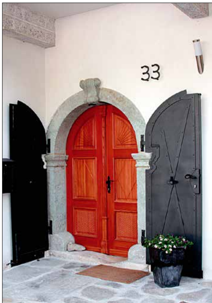
Lepo obnovljena vhodna vrata.
