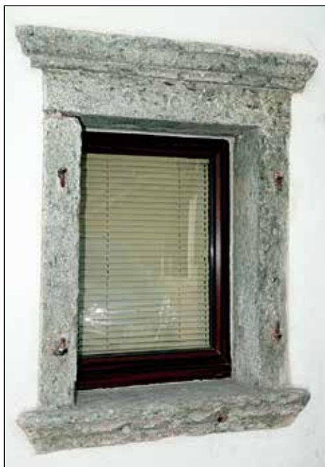
Okno s kamnitim okvirjem iz perachiškega tufa.
