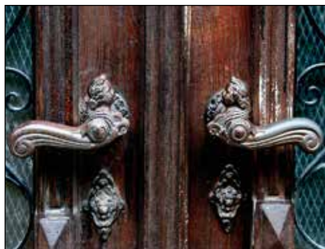
Detajl litoželeznih kljuk na vhodnih vratih.
