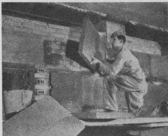
Montaža plutove izolacije — izdelek tovarne PLUTAL
