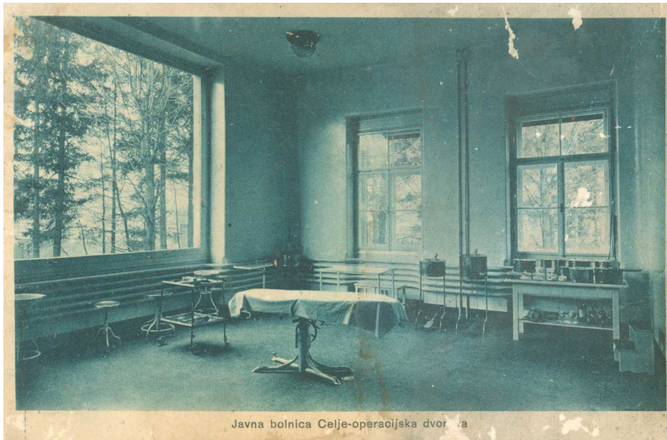
Skromna operacijska soba v bolnici Celje
