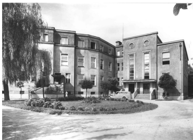
Stavba Ginekološko porodniškega oddelka (Vir: arhiv Splošne bolnišnice Celje)
