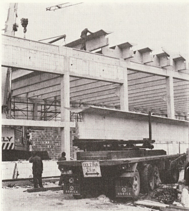
Montaža strehe oplemenitilnice, v ospredju prikolica za prevoz tovora z izredno dolžino
