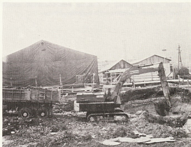
Izkop izravnalnega bazena za čistilno napravo tehnoloških odpadnih voda
