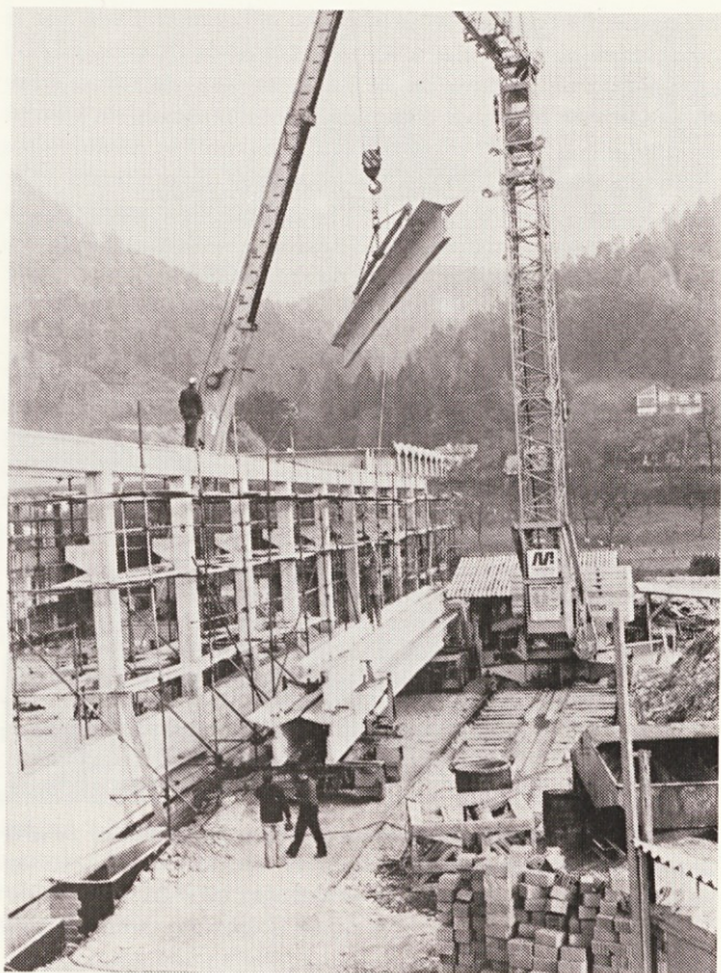
Polaganje „Y“ nosilcev za strešno oplemenitilnico
