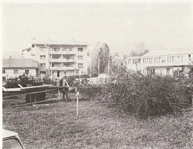
Najprej je bilo potrebno opraviti pripravljala dela na zazi-dalnem prostoru proizvodne hale Svile in uprave
