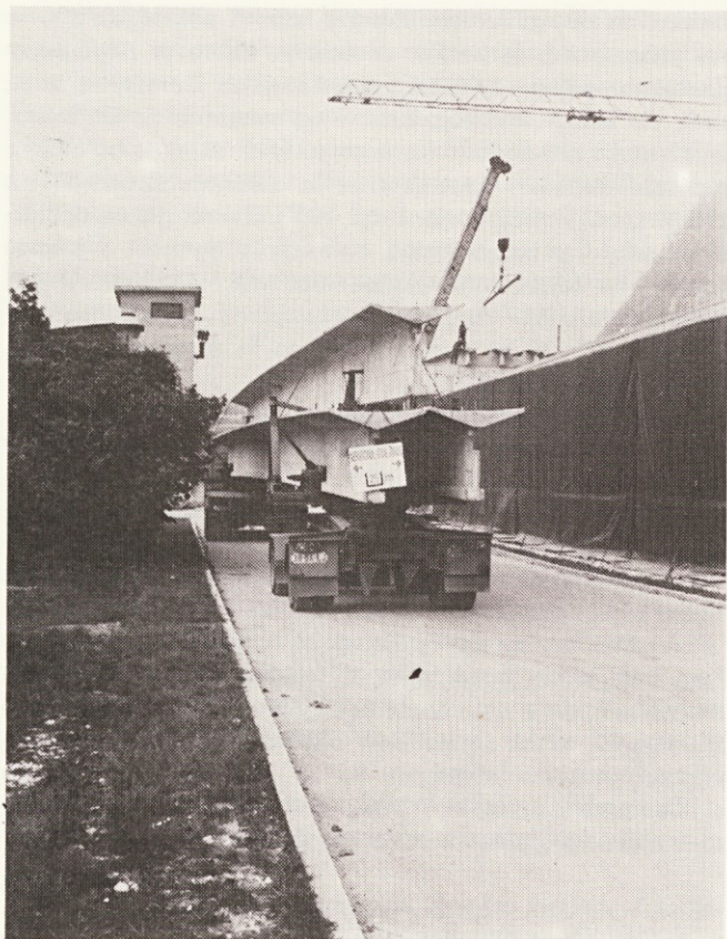
Končno so le prispeli v tovarno železobetonski nosilci (7 ton) za strešno konstrukcijo oplemenitilnice
