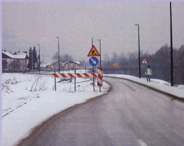
Po razlastitvi se bo dalo peljati po obeh pasovih. /Foto: Maja Bertonec
