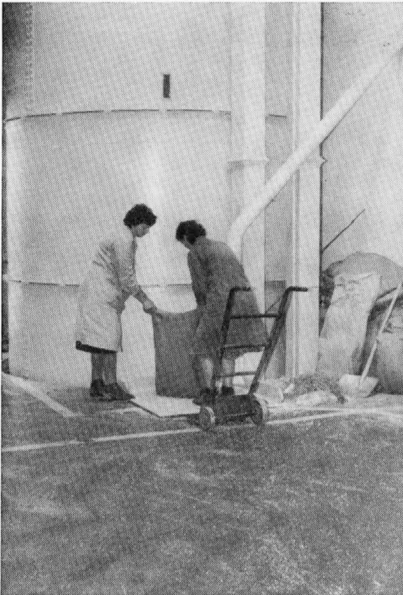
Delavki stresata riž v vsipni jašek silosa
