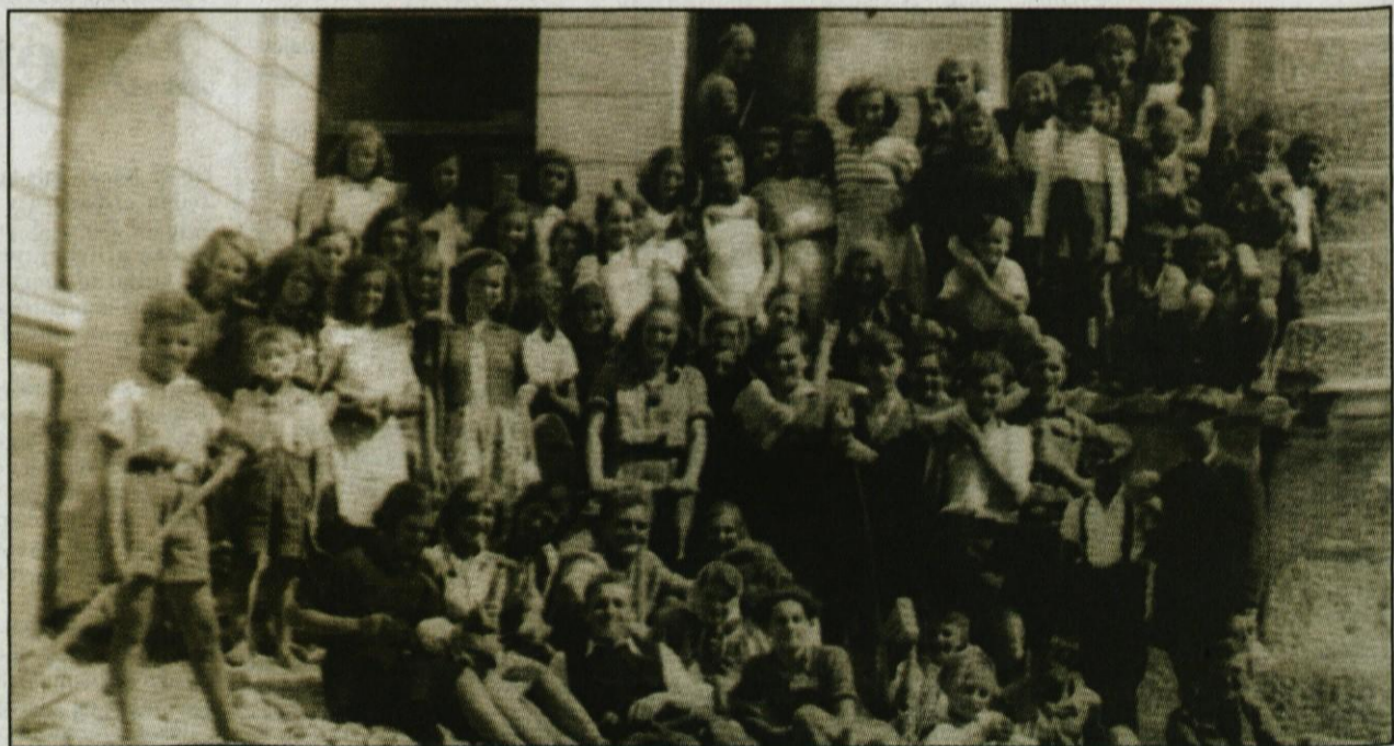
Po vojni so od sokolskega doma ostale le ruševine. Tako so v letih, ko se je vojna končala, napolnili učence domžalske osnovne šole, da so čistili ruševine. Zanimivo je, da je bil med čistilci tudi mladenič, ki je domnevno zažgal največje delo domžalskih sokolov.
