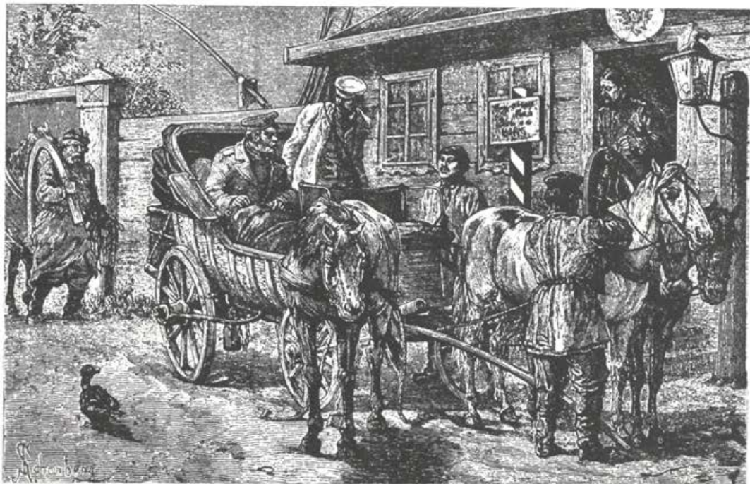
Ruska posebna pošta
