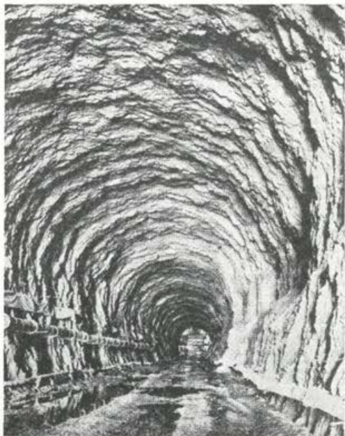
Hkrati z vrtnjem sproti polagajo cevi za vodo in zrak. Predor skozi Mont Blanc bo 9 m visok in 8 m širok
