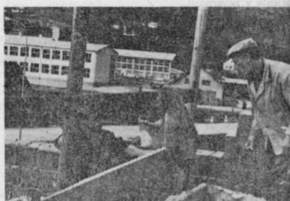
S sredstvi, ki so jih v glavnem prispevali občani Kozjanskega, grade v Kozjem nov gasilski dom. Leto ga bodo dogradili do strehe, prihodnje leto pa napredujejo pri gradnji nove šole je to druga največja akcija marljivih prebivalcev tega področja. Posnetek prikazuje delavca pri gradnji in pa del prostorov nove šole. (Foto: J. Sever)
