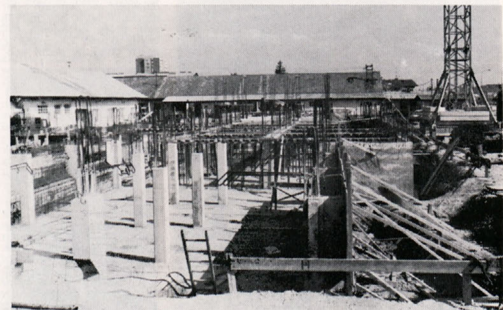
Na objektu poslovne zgradbe Ingrad opravljajo večino del učenci v gospodarstvu pod budnim očesom naših gradbenih inštruktorjev.
