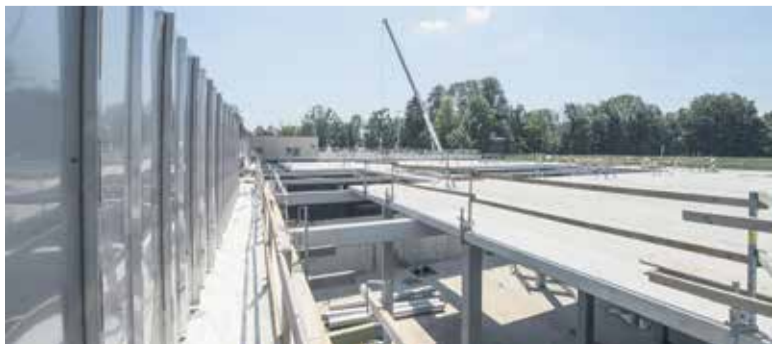
Nadgradnja CČN – marec 2016
