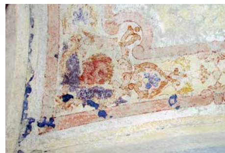
Stanje pred obnovo
