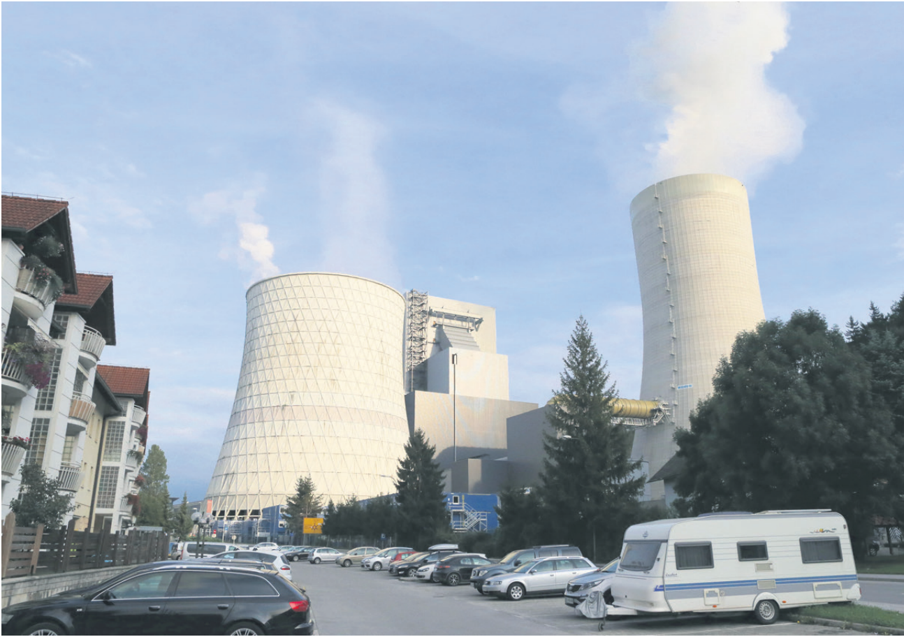
Pred zaposlenimi v Termoelektrarni Šoštanj je negotova prihodnost.
