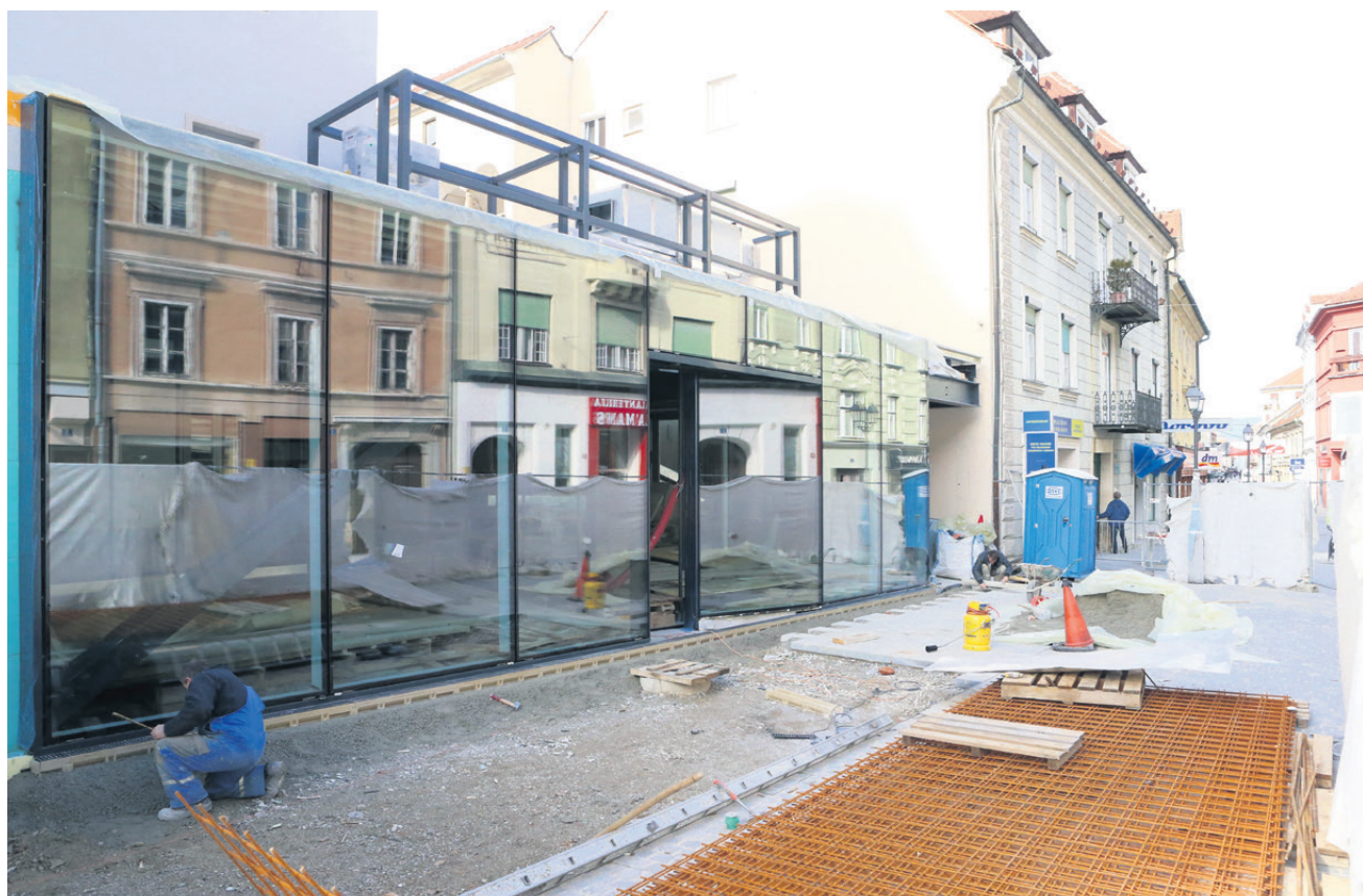
Gradnja paviljona na Glavnem trgu
