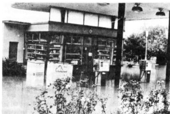
Voda je zalila bencinski servis PETROLA v Ilirski Bistrici
