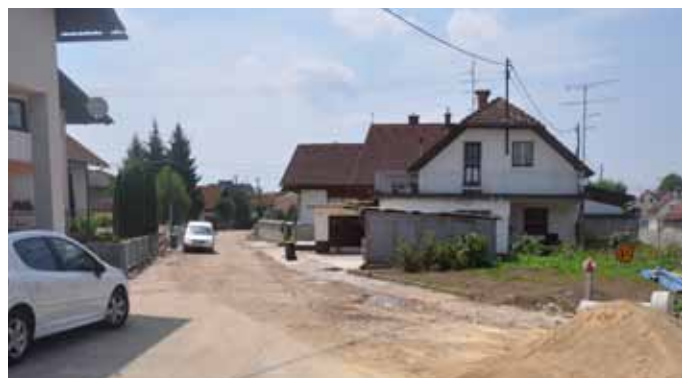
Zgradila oziroma zamenjala se bo tudi ostala komunalna infrastruktura
