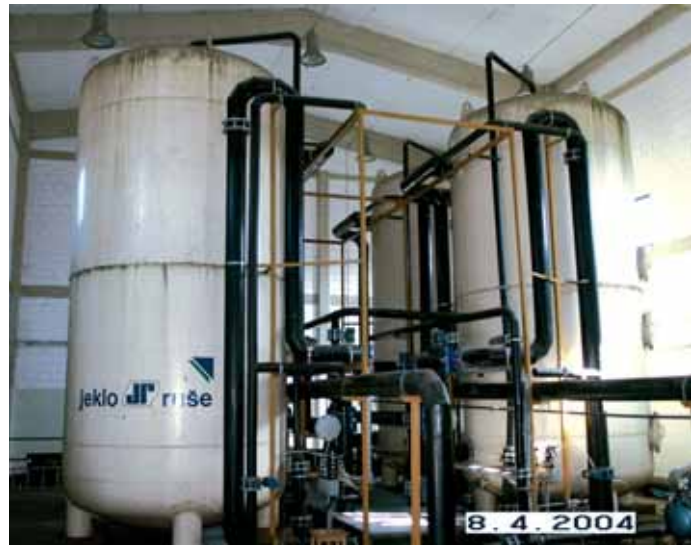
Slika 7 • Peščeni filtri in filtri z aktivnim ogljem na obstoječi čistilni napravi zagotavljajo dodatno kakovost in varnost pitne vode
