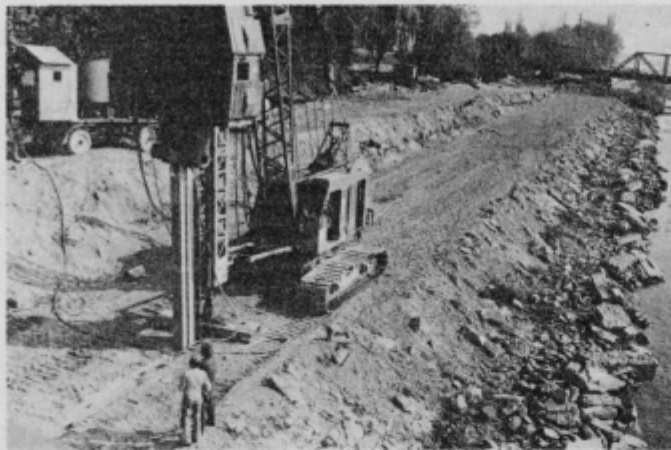
Zemeljska dela na levem bregu Drave — Foto: OM
