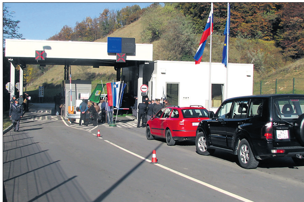
Novogradnja MP Zg. Leskovec (na isti lokaciji, kot je bil že prej) je zahtevala približno milijon evrov; 45 % sredstev je bilo pridobljenih iz evropskega sklada za zunanje meje.
