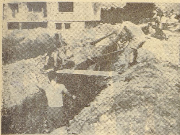
»Krepko so zagrabilo!« Tako je bilo mnenje o članih za družne gradnje, ki so solidarno izkopali jarek za polaganje vodovodnih cevi na Klanecu v Kranju
