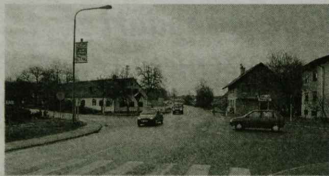
Bodo zapletti pri gradnji krožišča v Mostah pravočasno rešeni?
