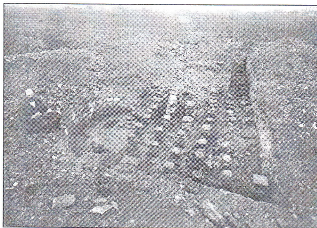
Slika 2: Tloris zidov rimske vile, ki jo je izkopal Fran Kovačič, in fotografija hipokavsta (talnega gretja) vile. (Načrt po Trg Središče, 1910; foto: fototeka Pokrajinskega muzeja Maribor)
