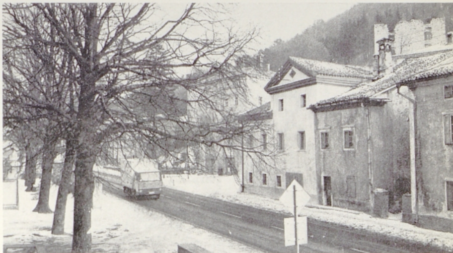
Skozi Senožče pelje pomembna cesta iz Postojne proti Sežani in Trstu in na levo stran v Koper, Izolo, Portorož in Piran, in seveda tudi naravnost v Istro
