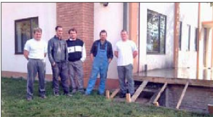
Mojstri pri urejanju betonske plošče pri domu krajanov Dolena
