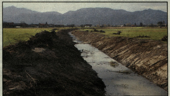
Del očiščenega razbremenilnega kanala
