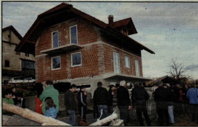
Nova hiša Ločanovih
