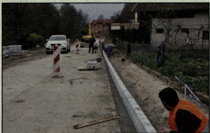
Gradnja prve faze pločnika v Zabukovici
