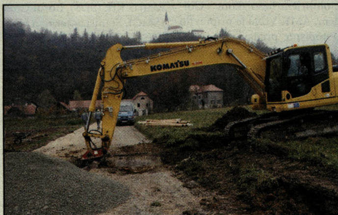
Rekonstrukcija lokalne ceste Vransko-Tešova
