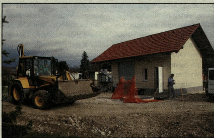
Gradnja črpališča vakumske postaje v Malih Braslovčah
