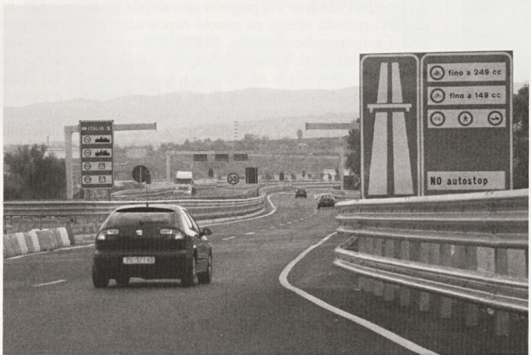
Od italijanskega mejnega prehoda do prvega tunela že po novi avtocesti.
