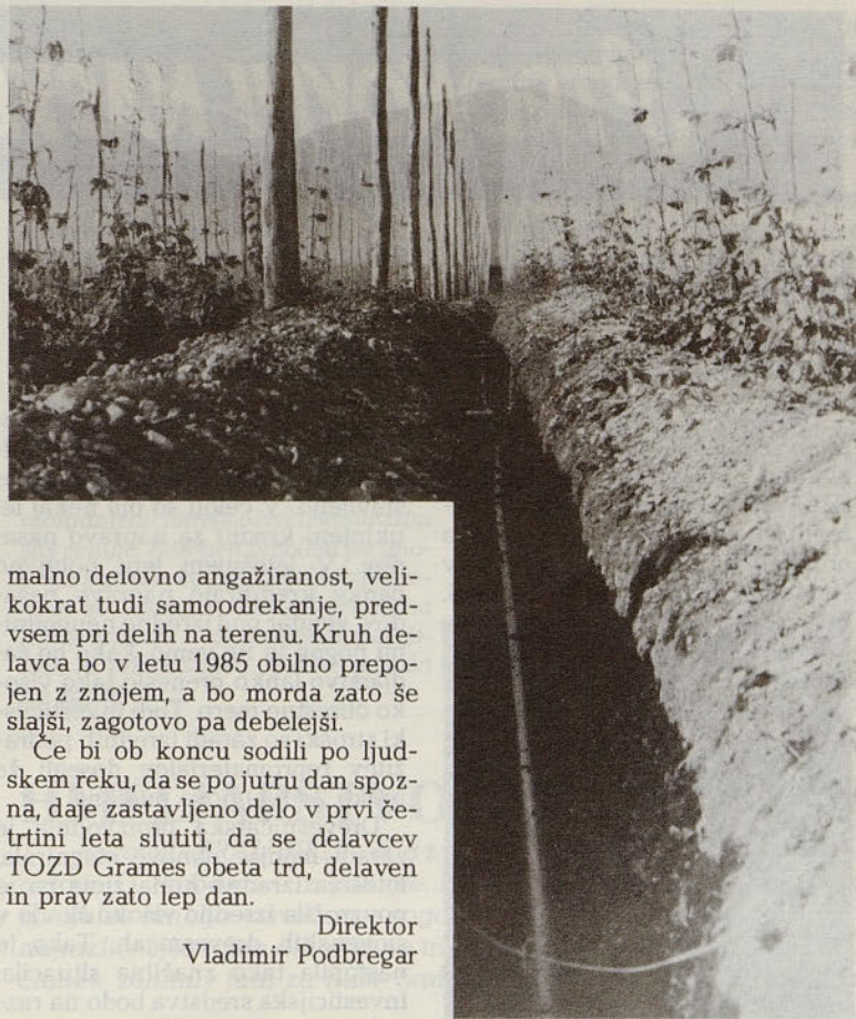
Vkopana cevna mreža za namakalni sistem v hmeljišču
