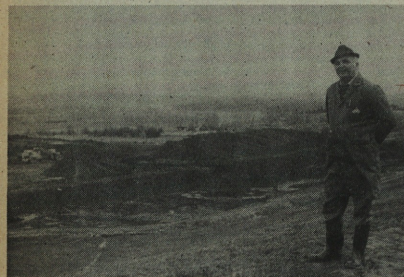
Delovodja Stanko Kostanjevec je kljub blatu in brozgi na gradbišču dobre volje, saj je star maček za tovrstno delo
