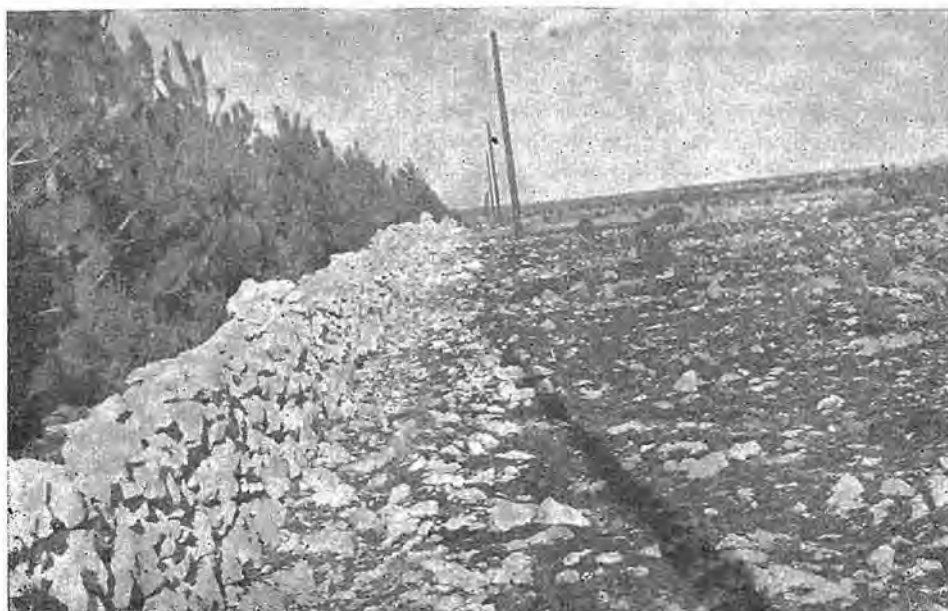
Borov nasad, zavarovan s protipožarnim zidom in ob njem še z 1 m širokim, vedno čistim pasom (orig.)
