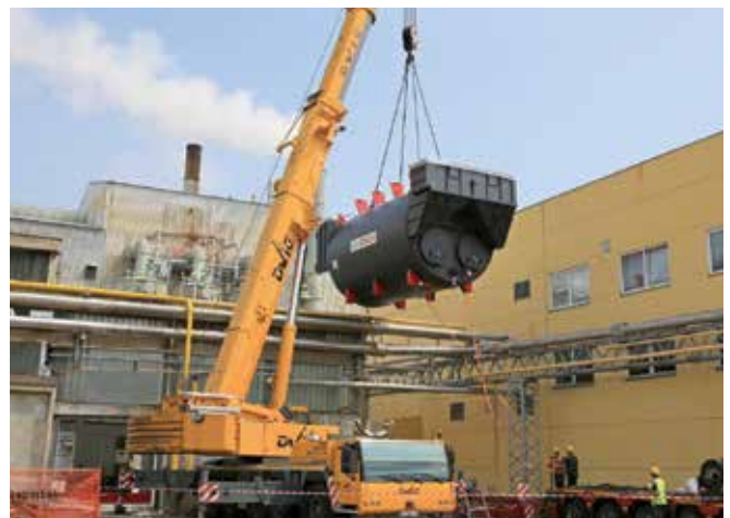
Za transport je bila uporabljena posebna prikolica s kar 11 osmi in 44 kolesi. Pri postavitvi kotlov se je uporabljalo avtodvigalo nosilnosti 200 t. (Foto: Blaž Črepinšek)
