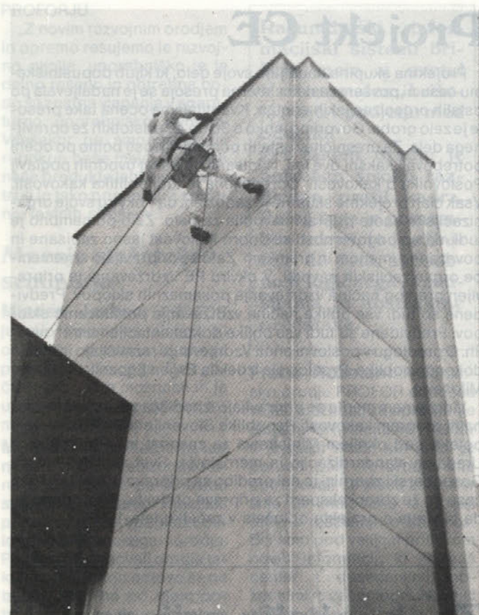
Na objektu PETROLA v Ljubljani so impregnirali fasado, ki je izdelana iz naravnega kamna, z našim izdelkom Aquastopom.
