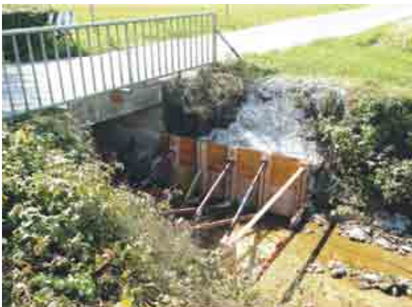
Sanacija brežine ob mostu v Dobu
