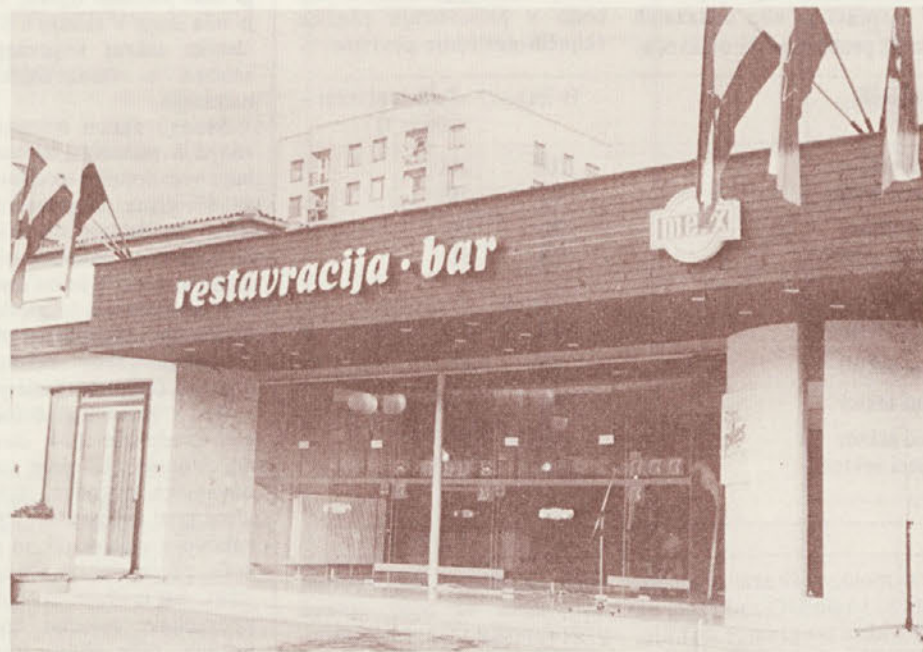
Hotel Merx v Ravnah na Koroškem
