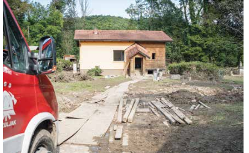
Poplavljen hiša je neprimerna za bivanje.
