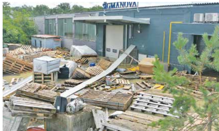
V Sigmanovi je voda segla tudi 4 metre visoko.
