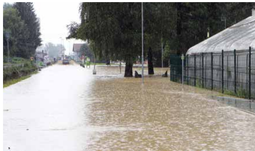
Območje IHPS je v celoti plavalo in tudi v stavbo prineslo pol metra blatne vode.
