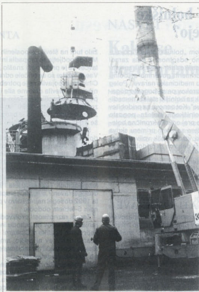
Nov razlivni sistem v sušilnem stolpu
