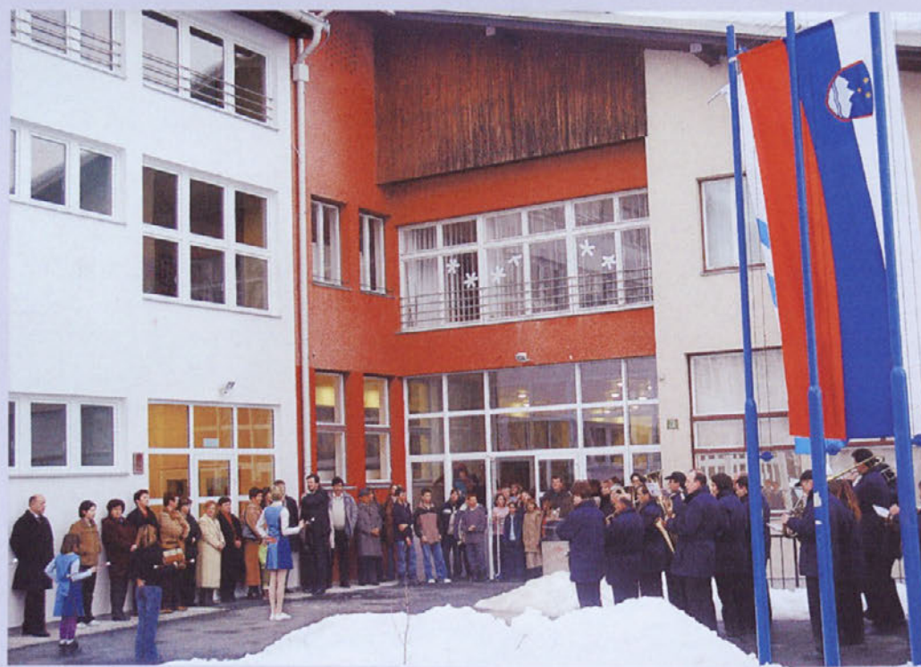
Z gradnjo prizidka k šoli v Smledniku so začeli lani poleti.
