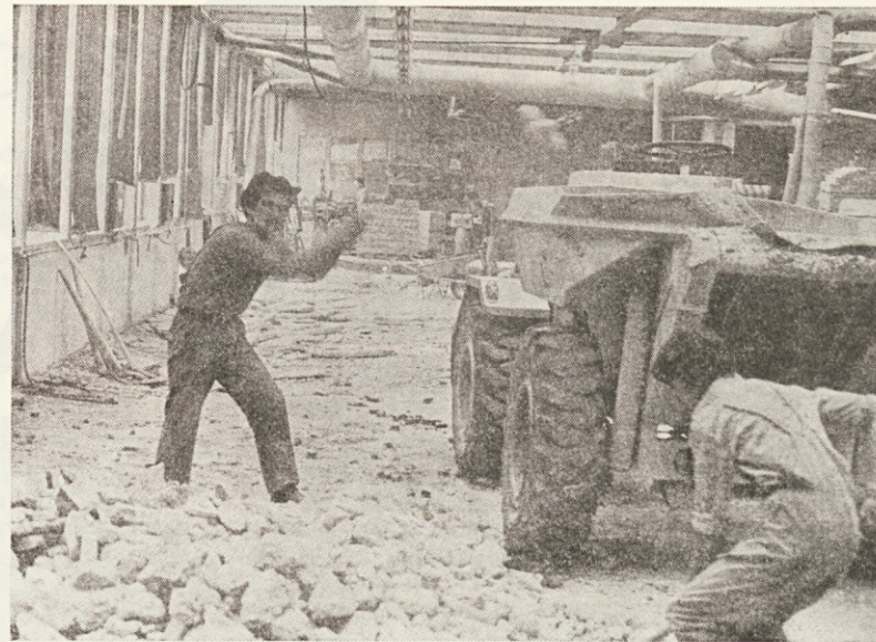
Rekonstrukcijska dela v naši temeljni organizaciji MASIVA v Martinjaku
