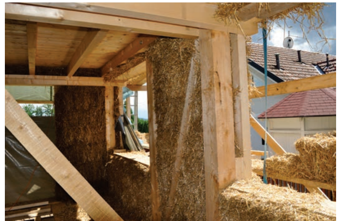
Slika 4: Lesen skelet s polnilom iz bal slame.
