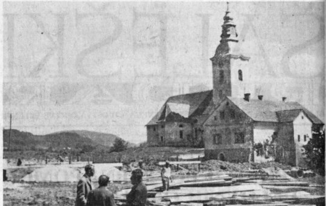
Na tem kraju so začeli v Sentilju graditi novo šolsko poslopje. Stara šola (v ozadju) je povsem neprimerna za poučevanje
