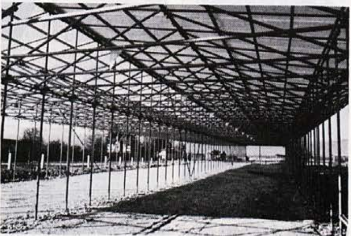
Novo ostrešje na skladišču čolnov, predvsem večjih
