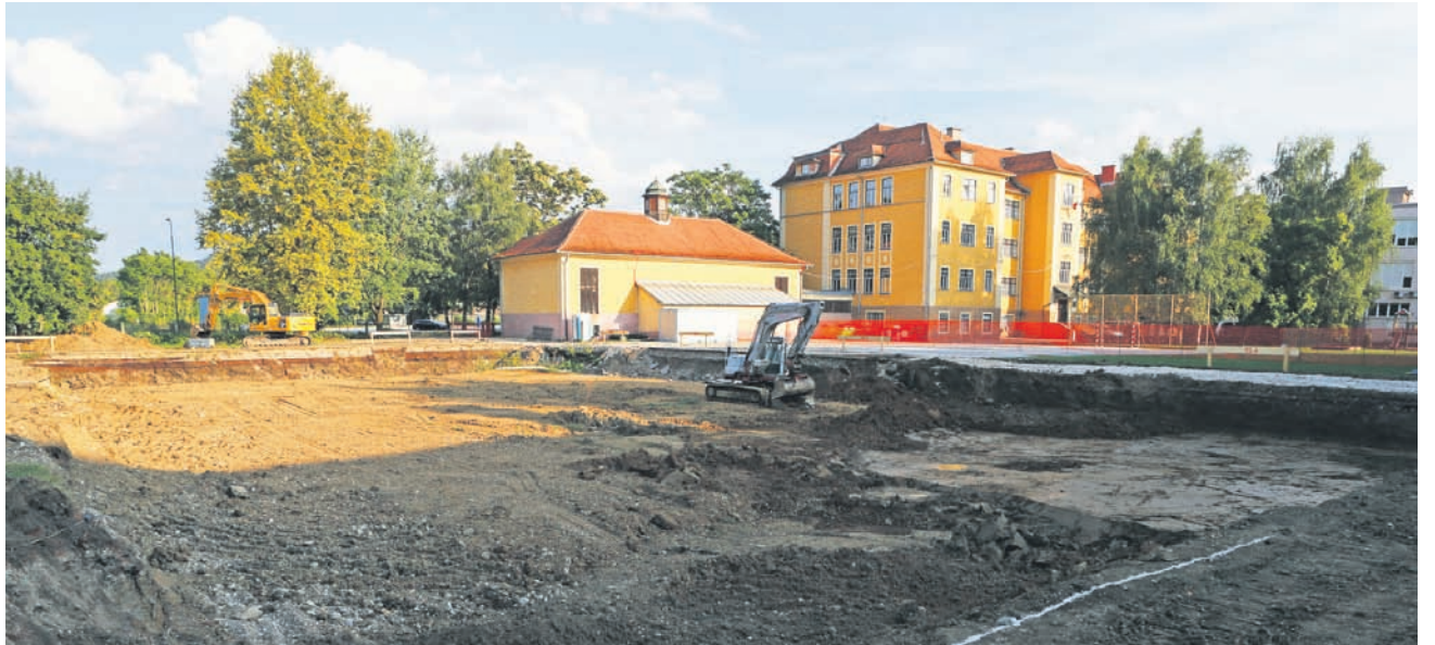
Pri I. OŠ v Celju so pred kratkim začeli graditi novo telovadnico, ki naj bi bila končana do marca 2018.
