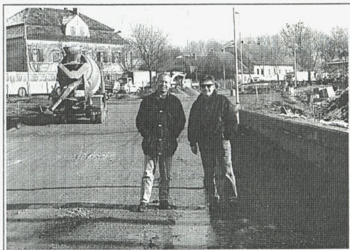
Izvajalec podvoza je zadovoljen z že opravljenim delom, prav tako nadzorna služba z ing. Radetom Zeljkovičem na čelu.
