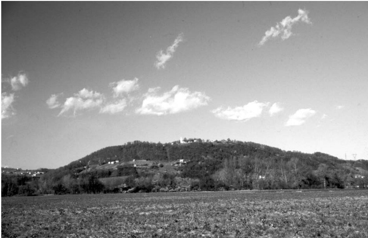
Sl. 3: Libna. Pogled z jugozahoda. Abb. 3 Libna. Blick von Südwesten.
