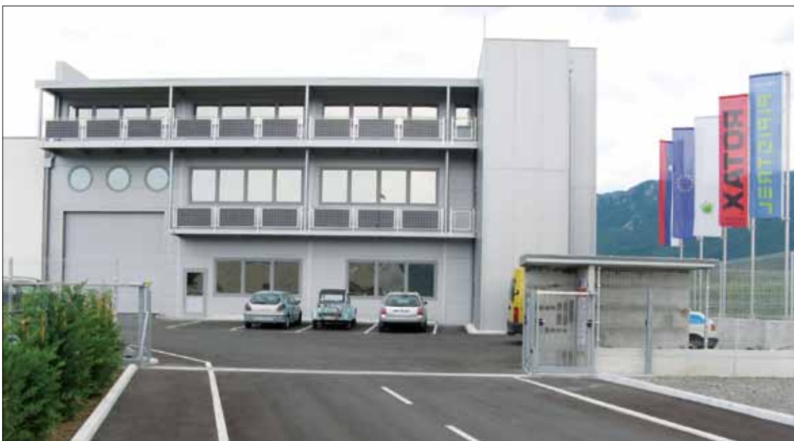
Raziskovalni inštitut za naprave za zajem obnovljivih virov energije
