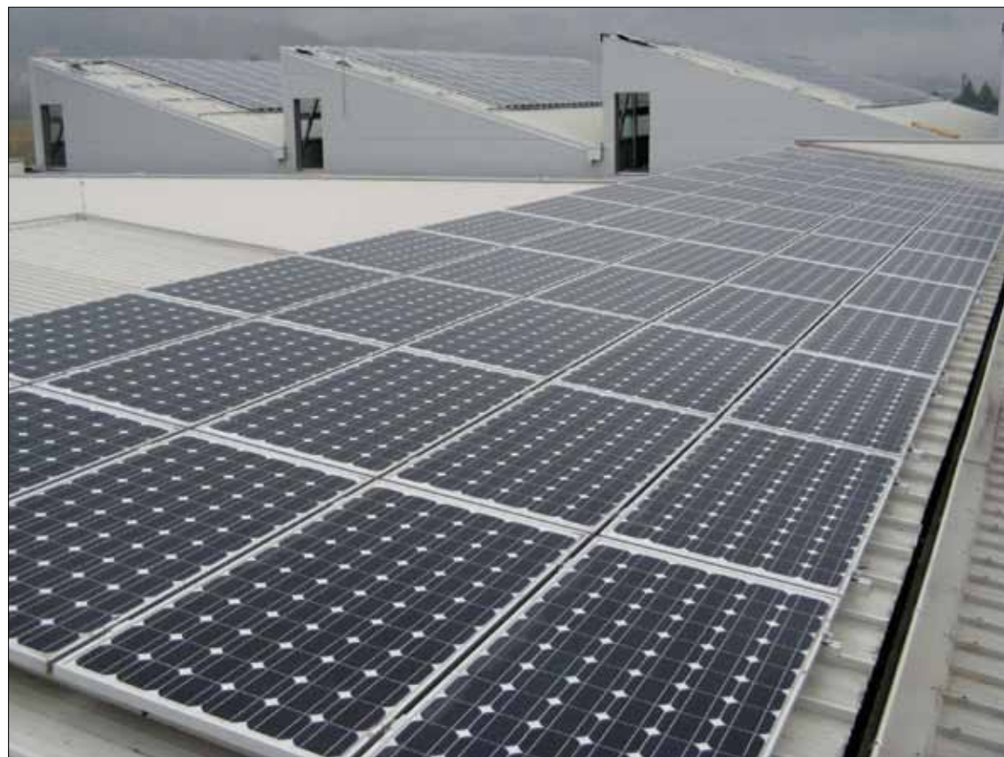
Sončna elektrarna na strehi objekta v fazi gradnje
