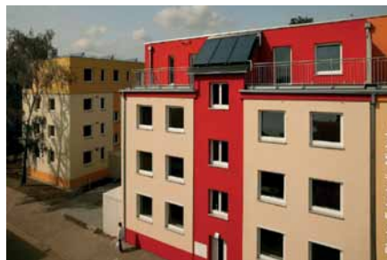
Slika 12: Nova fasada in sončni kolektorji na strehi stopnišča stanovanjskega objekta v Frankfurtu
