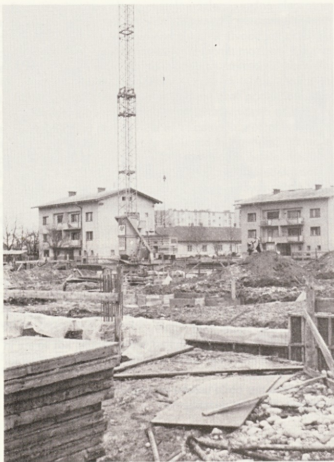
Na sliki se vidi del opaža temeljev za katere so bile porabljene velike količine betona.
