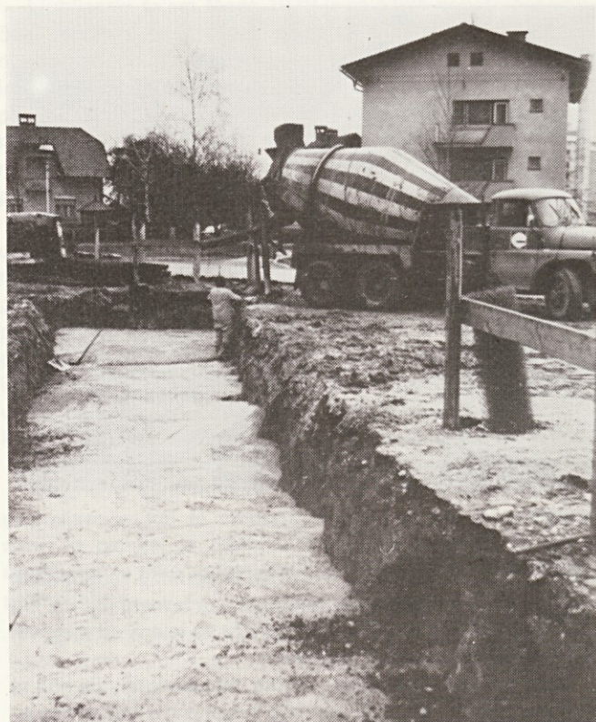
Betoniranje poglobljenih temeljev za objekt upravne zgradbe ob Kovinarski cesti.
