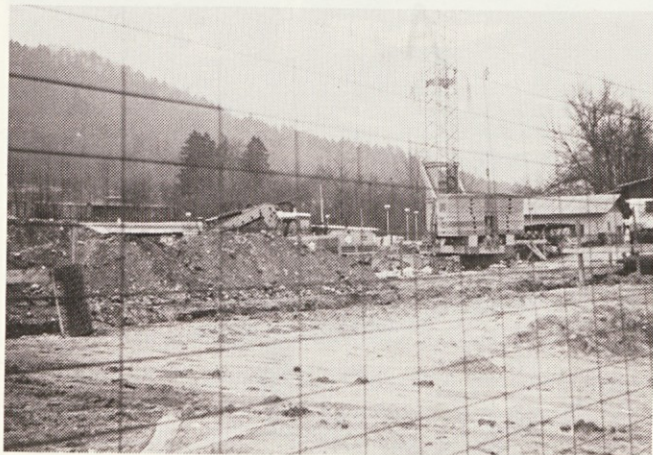
Vsled slabe nosilnosti tal je bilo treba poglobiti temelje tako pri proizvodnem objektu svile kot pri upravi.
