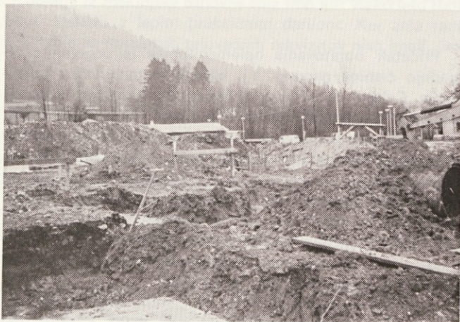
Na gradbišču so se začela zemeljska dela za proizvodni objekt svile.
