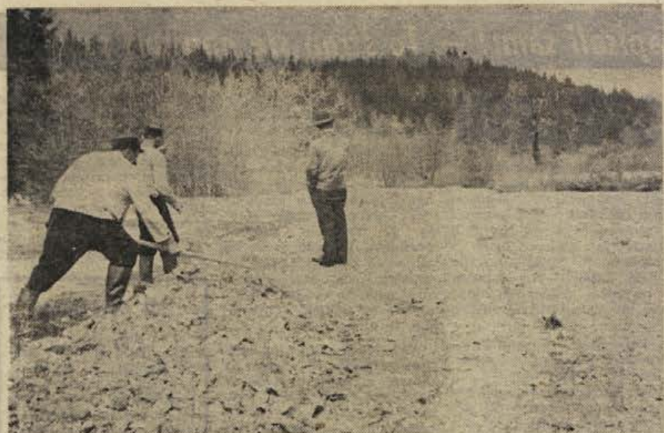
Cesta od Rašice do Dobrepolja, dolga kakih sedem kilometrov, je na nekaterih mestih hudo razdejana. Najbolj jo je poplava Rašice prizadela tik pred Ponikvami, nedaleč od Rašice, koder skoraj ni bila več prevozna. Delavci cestnega podjetja so jo nedavno zasilno popravili. Na najbolj ogroženem delu cestišča so morali nasuti veliko materiala in cestišče precej dvigniti. Dobrepoljci že vrsto let želijo, da bi asfaltirali cesto do njihove doline, in bi bili pripravljeni tudi sami prispevati. Zal nekaj naslednjih let ne bo nič, ker bodo vse sile in denar usmerili v gradnjo vodovoda. (Foto: Grivec)
