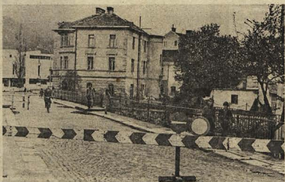
Most na Roški cesti v Kočevju, ki je bil zgrajen leta 1843, je dotrajal in je potreben temeljitega popravila, ki se bo zavleklo še nekaj mesecev. Zaradi svoje starosti in posebnih obokov ga je Zavod za spomeniško varstvo zaščitil, kar pomeni, da tudi po obnovi svojega videza ne bo bistveno spremenil. (Foto: Primc)
