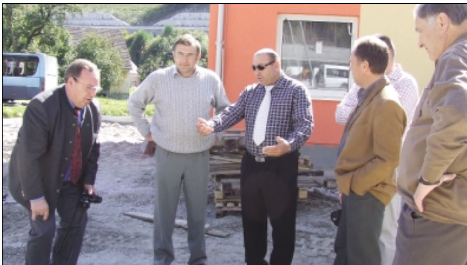
ogled gradnje osnovne šole v Blagovici
